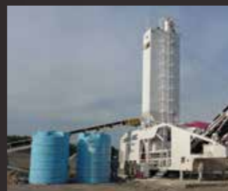
Строительство плотины Мексика
