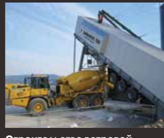
Строительство ветровой электростанции Шотландия
