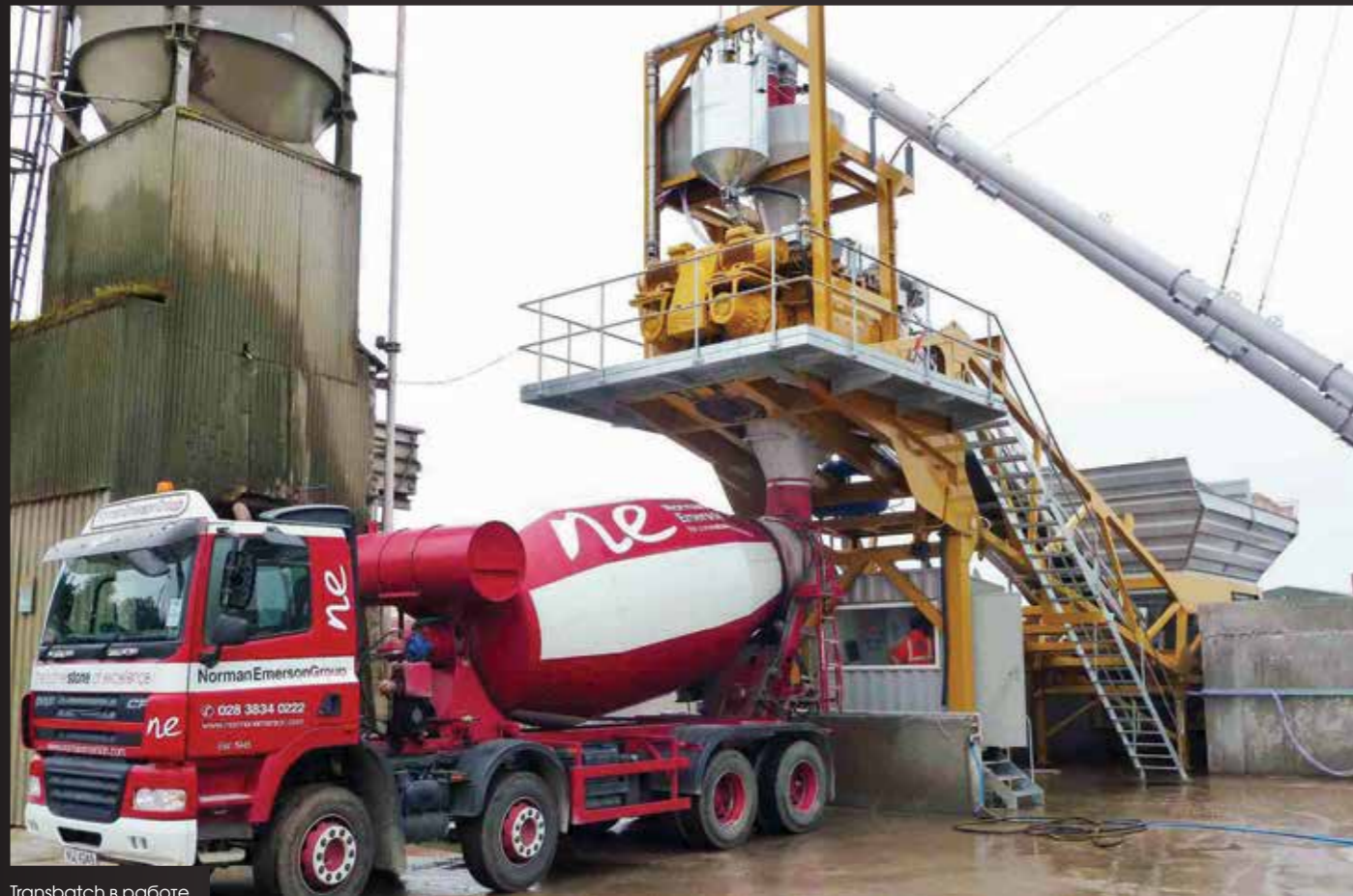
Transbatch в работе
