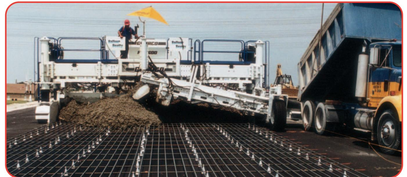
Бетонораспределитель PS-2600 использовался для распределения бетонной смеси на основание при устройстве армированного дорожного покрытия.
