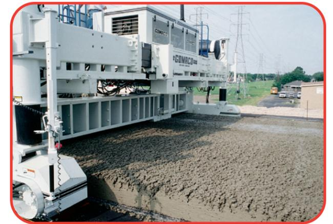
Бетонораспределитель PS-2600 оснащен профилирующим рабочим органом шириной 7,32 м, который включает в себя центральную регулируемую вставку. Дополнительные секции позволяют увеличить ширину полосы распределяемой бетонной смеси.
