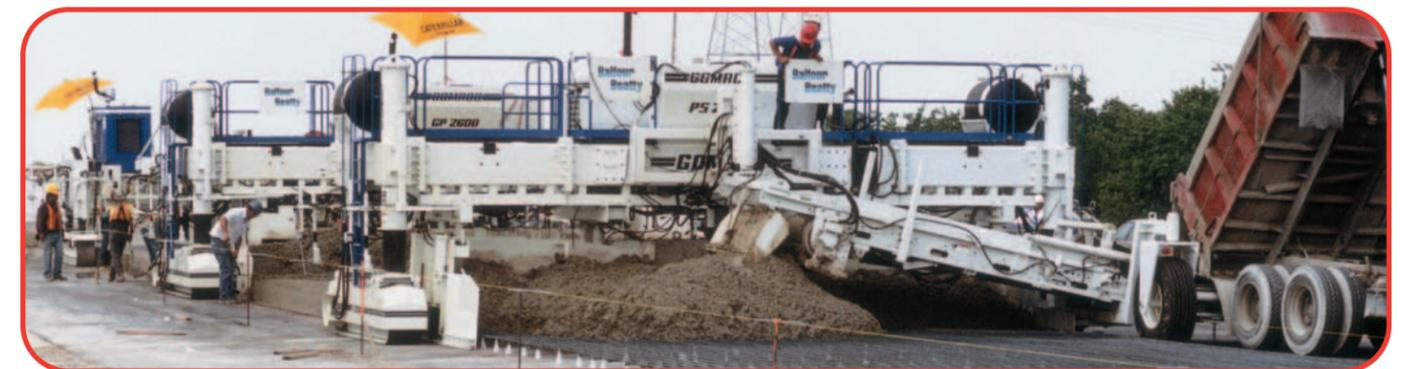
Бетонораспределитель PS-2600 оборудован разгруженными от бокового давления скользящими формами, позволяющими распределять бетонную смесь слоем толщиной до 483 мм.
