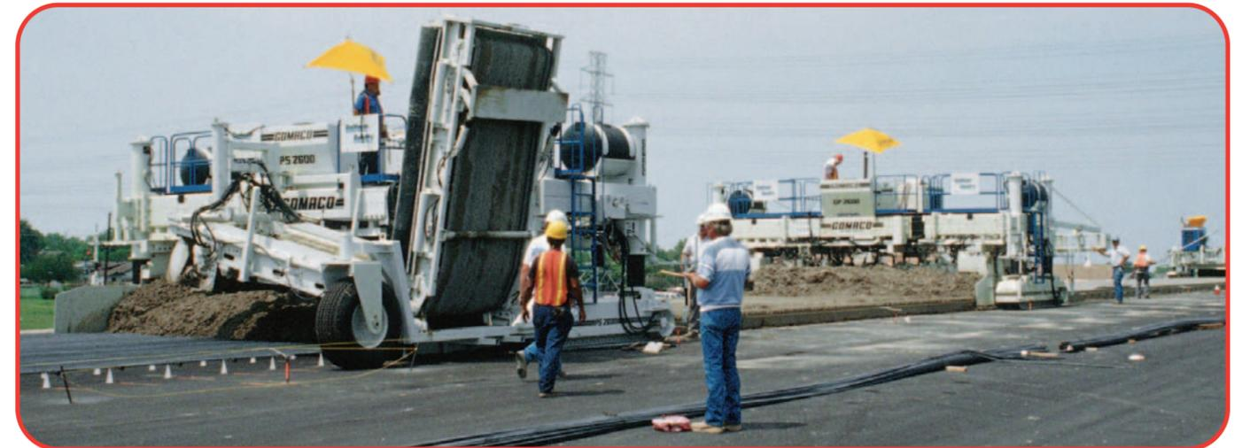
Комплект бетоноукладочных машин корпорации GOMACO, состоящий из бетонораспределителя PS-2600, бетоноукладчика со скользкими формами GP-2600 и машины T/C-600 для образования шероховатости на поверхности покрытия и распределения пленкообразующих материалов, обеспечивает высокую производительность работ и прекрасное качество поверхности укладываемого покрытия.
