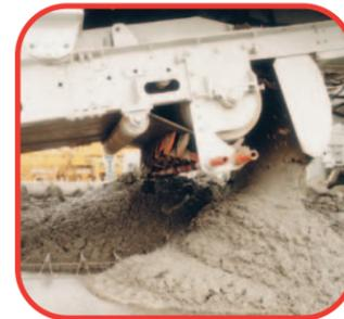
С помощью отражателя можно изменять направление потока бетонной смеси, поступающей с ленты конвейера на основание.
