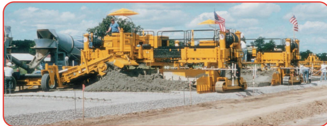
Уникальная телескопическая секция длиной 1,98 м на левой стороне рамы машины позволяет приспособить бетонораспределитель для работы с переменной шириной укладываемой полосы.
