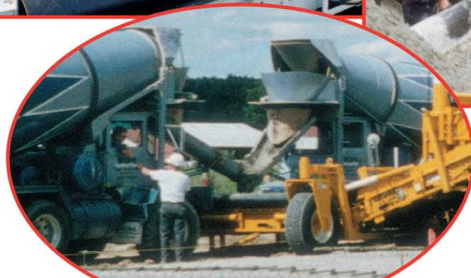
С помощью двухсекционного винтового рабочего органа диаметром 508 мм с приводом от реверсивных гидромоторов осуществляется быстрое и аккуратное распределение бетонной смеси по ширине строящегося покрытия.
