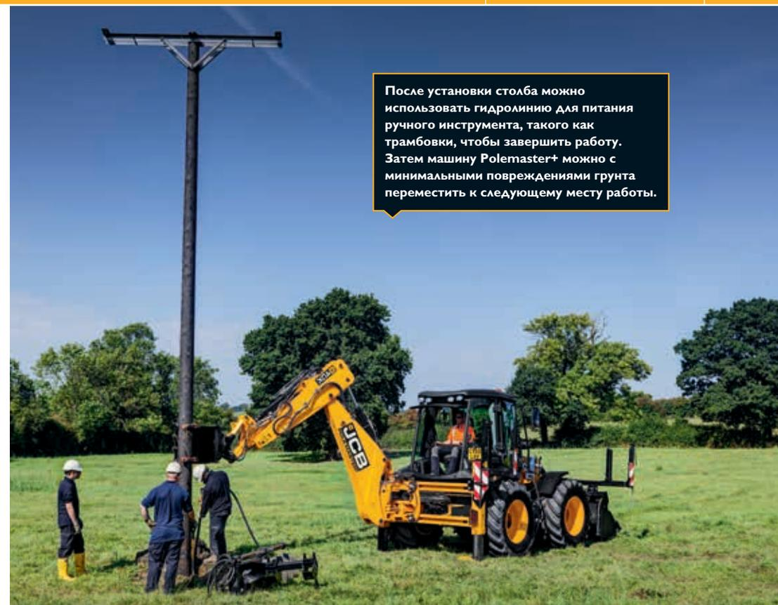
После установки столба можно использовать гидрولينию для питания ручного инструмента, такого как трамбовки, чтобы завершить работу. Затем машину Polemaster+ можно с минимальными повреждениями грунта переместить к следующему месту работы.
