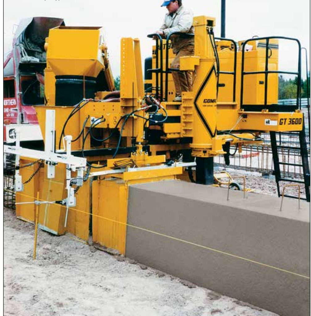
GOMACO GT-3600 бетонировать фундамент катка для фигурного канала в Мичигане
