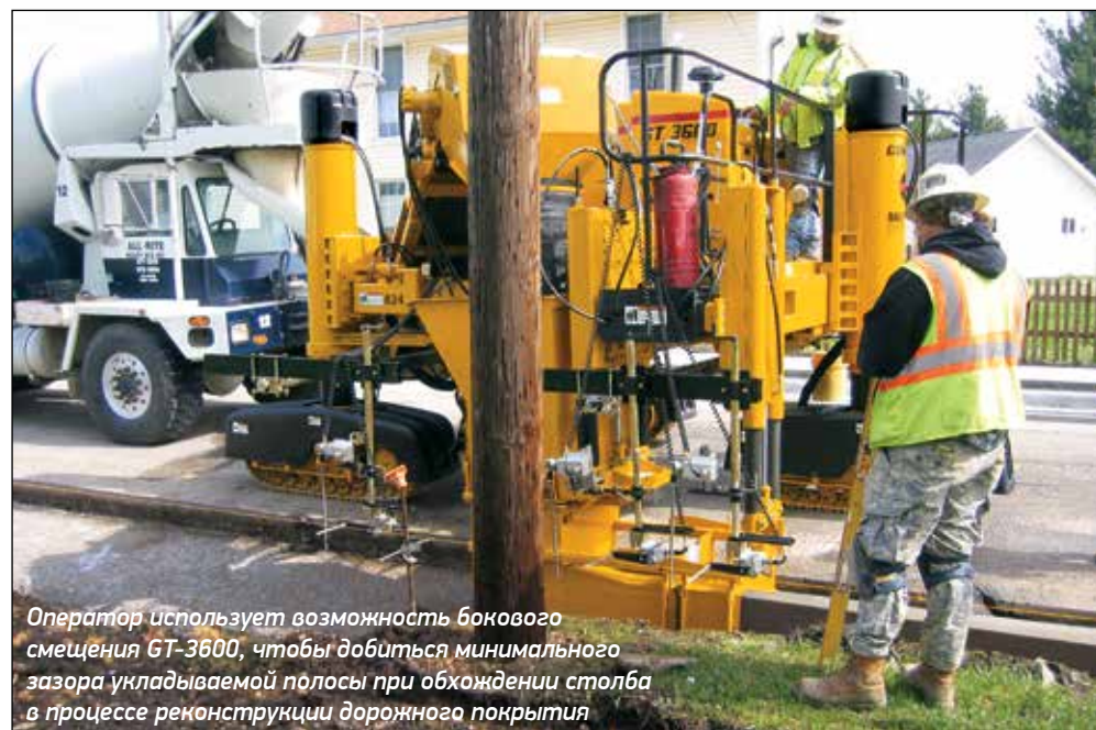
Бетоноукладчик GT-3600 обустривает в скользящей опалубке бордюр толщиной 406 мм (Канада)
