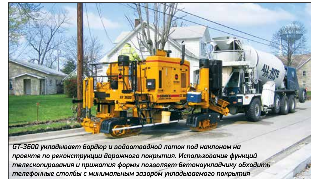
Система позиционирования всех гусеничных тележек (АТР) обеспечивает простоту настройки для укладки в скользящей форме пешеходных дорожек. Курс и высота бетоноукладчика определяется с учётом существующего бордюра
