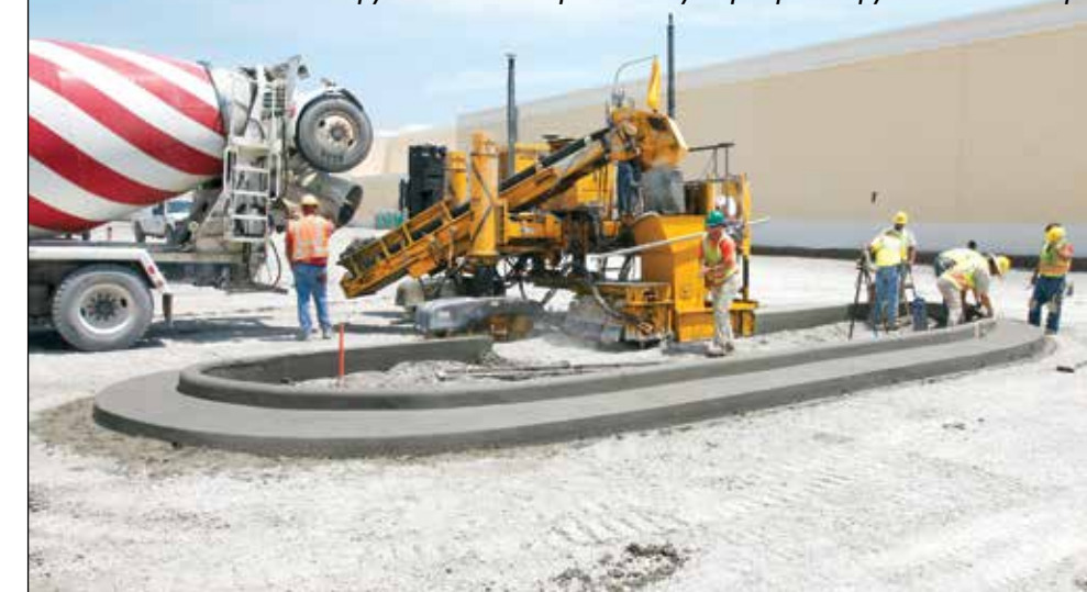
Бетоноукладчик GT-3600, оснащённый бесструнной системой нивелирования Leica Geosystems 3D, укладывает профиль в скользящей форме с малым радиусом на проекте по устройству автомобильной парковки. Перед началом укладки парковочной зоны автобетоносмеситель загружает смесь в приёмный бункер через загрузочный конвейер
