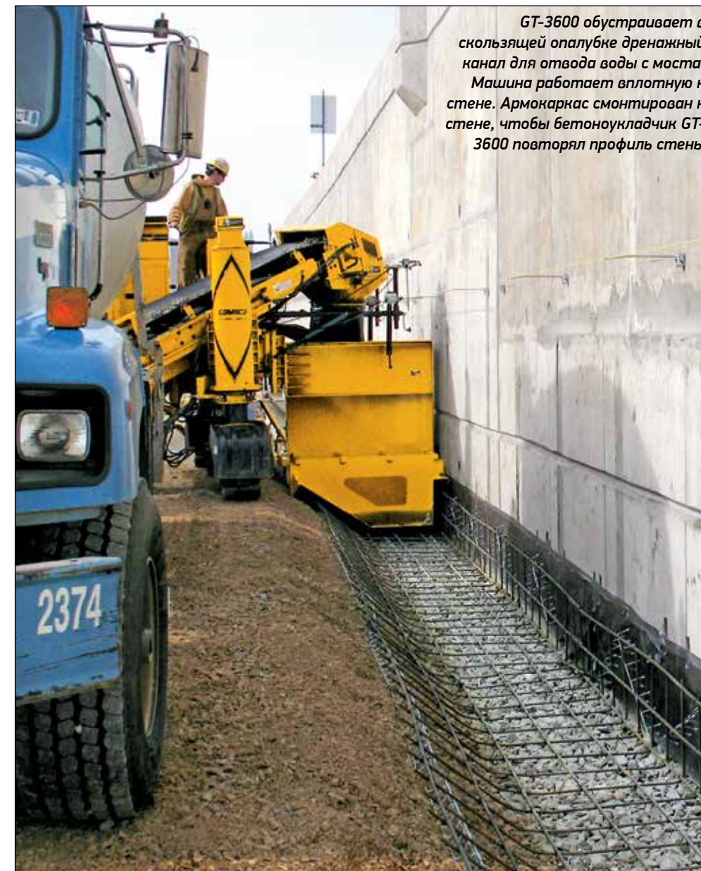
Рабочий вручную производит финишную отделку покрытия на проекте по обустройству дренажного канала
