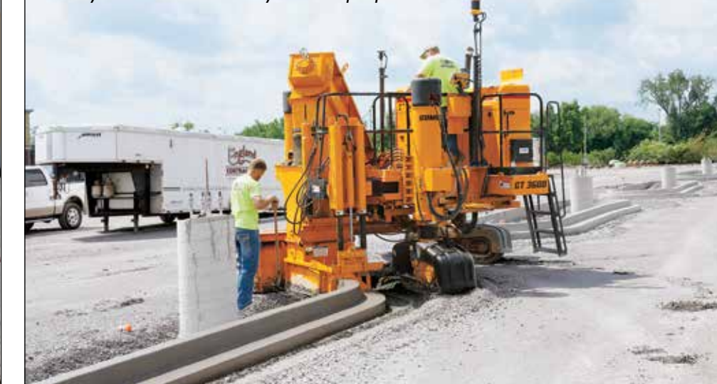
16 малых парковочных зон и одна большая по центру были обустроены в первый день работы. Этот день также стал и первым днём работы подрядчика с системой нивелирования Topcon 3D, встроенной в систему управления GOMACO G+ бетоноукладчика GT-3600 для укладки бордюров и водоотводных лотков
