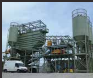
Производство бетона: Aggregate Industries - Bardon Глазго, Шотландия
