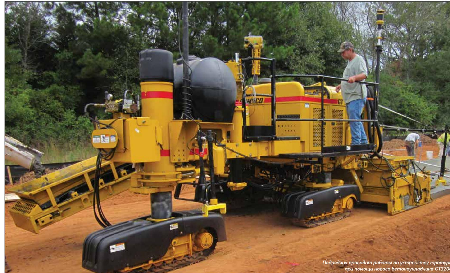
*Подрядчик проводит работы по устройству тротуара при помощи нового бетоноукладчика GT3200*
