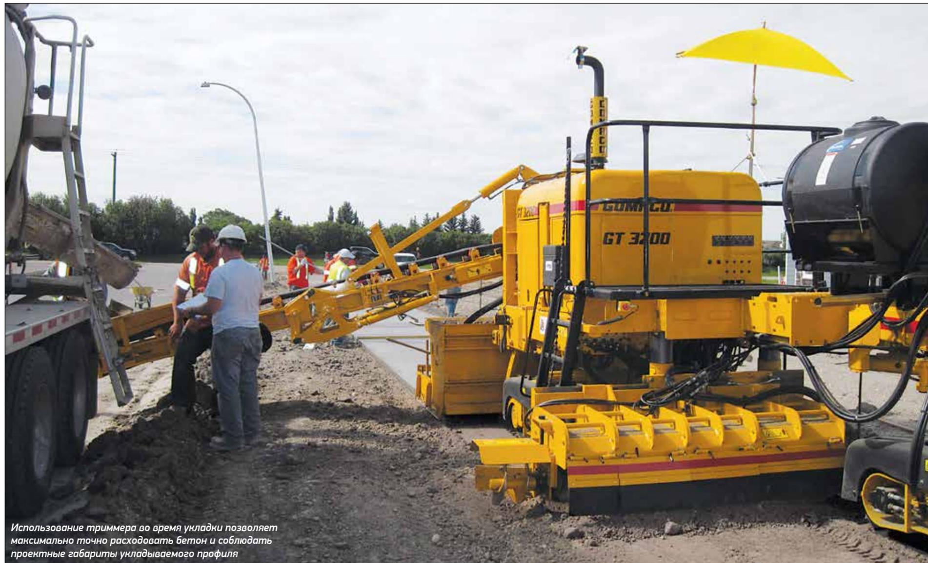
Использование триммера во время укладки позволяет максимально точно расходовать бетон и соблюдать проектные габариты укладываемого профиля
