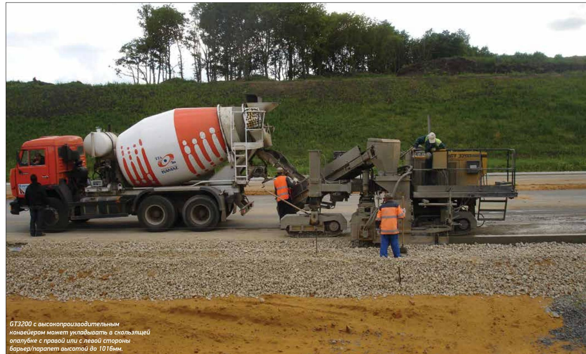
GT3200 с высокопроизводительным конвейером может укладывать в скользящей опалубке с правой или с левой стороны барьер/парапет высотой до 1016мм.
