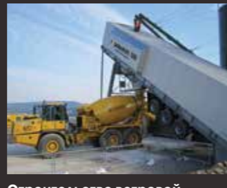
Строительство ветровой электростанции Шотландия
