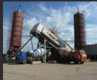
Производство бетона Россия
