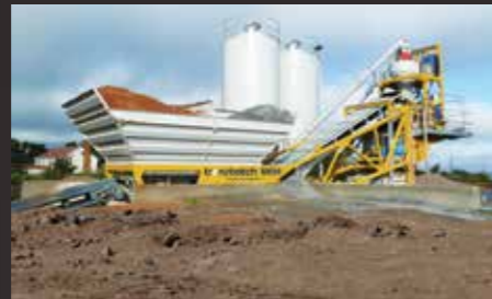
Производство бетона Северная Ирландия
