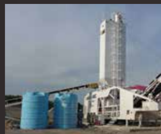
Строительство плотины Мексика
