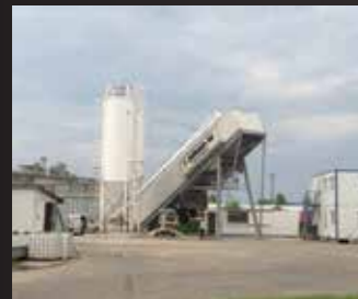
Строительство аэропорта Латвия
