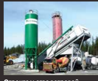
Строительство ветровой электростанции Швеция
