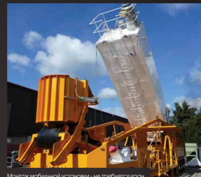
Монтаж мобильной установки - не требуется кран
